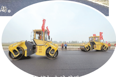
摊铺机匀速前进。
