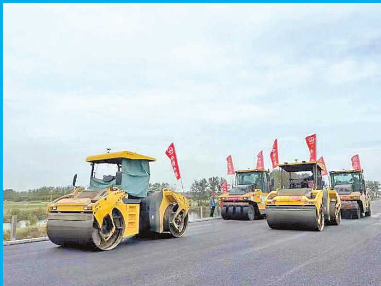
沥青上面层碾压施工。
