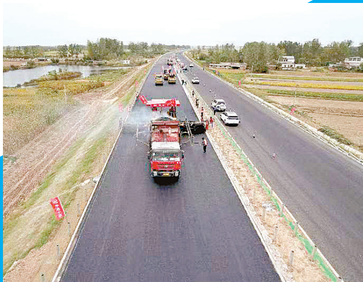
沥青上面层摊铺现场。
