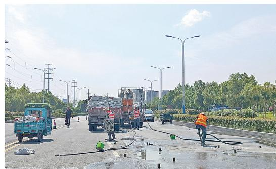
本报讯(文/图 全媒体记者 王永良)5月24日上午,记者在市区汝河大道中段看到,十几名道路施工人员正在用一体化注浆装置对道路地基进行注浆施工(如图)。
