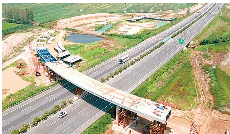
本报讯(文/图 全媒体记者 张勇)7月20日,随着沈遂高速常庄枢纽互通CK1+329.908 C匝道2号桥的钢箱梁顶推施工顺利完成(如图),标志着常庄枢纽互通这一重要节点的顺利推进,为后续工程建设奠定了坚实基础。
