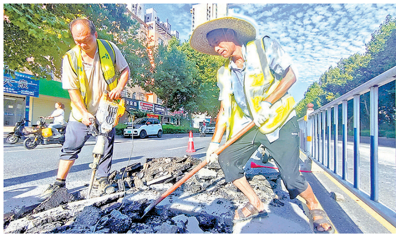
养护工人在修理路面
