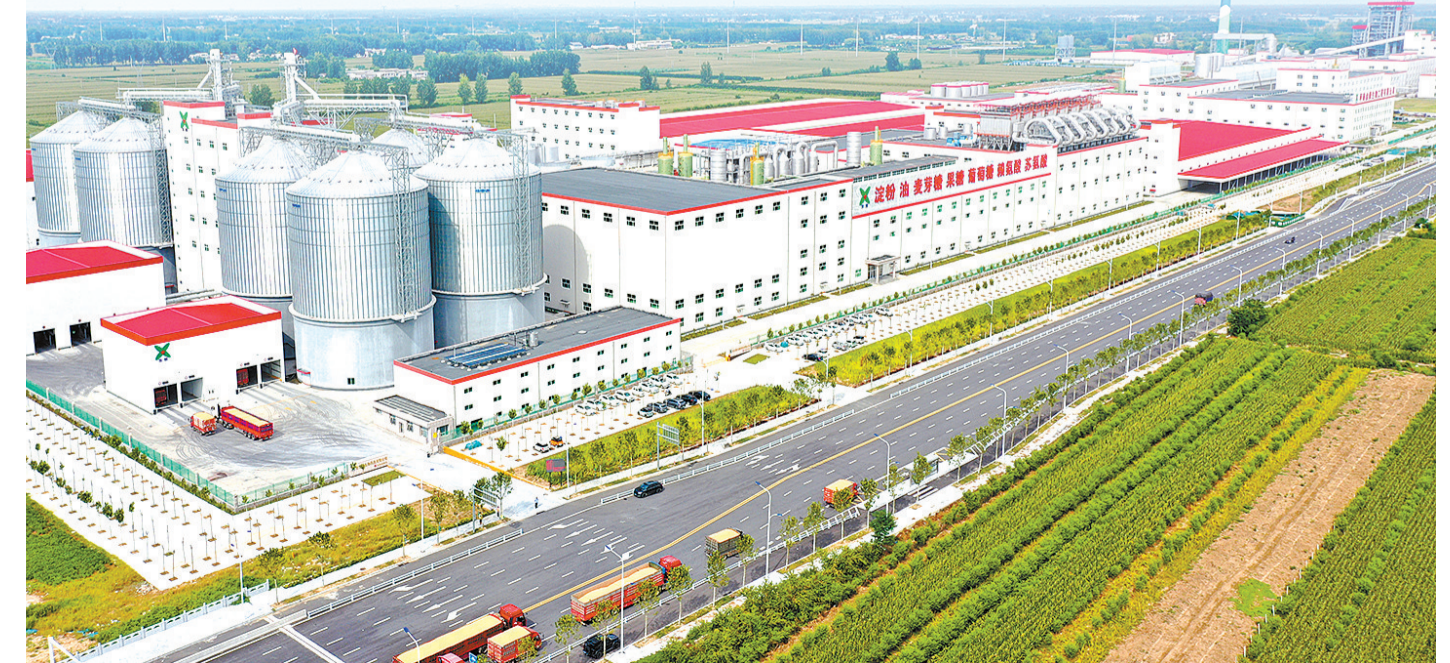
一期已投入生产的河南金玉锋大健康产业园项目
