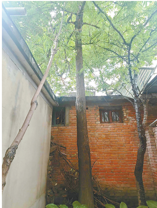
椿树紧邻居民楼。
