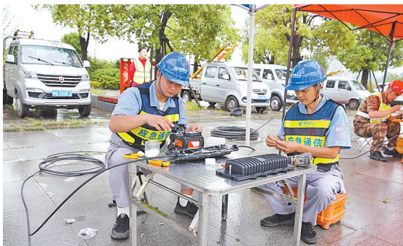
光缆线路抢修。
