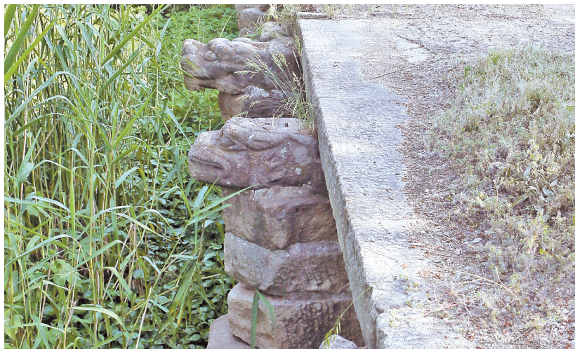
兴隆桥跨越近千年，威风犹存。
