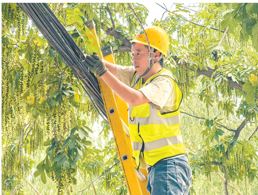
施工人员作业忙。
