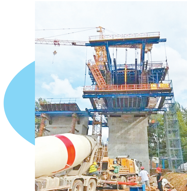
溱头河大桥挂篮浇筑施工现场。
