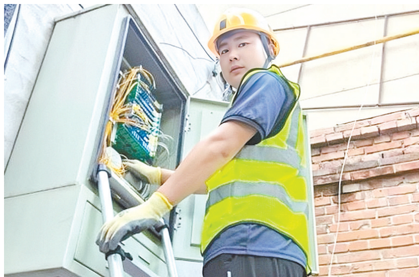
维修人员排查线路。
