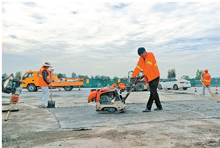
确山县公路部门对路面坑槽进行养护作业。
